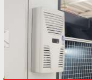
Elektrik Kabin Soğutma Sistemi
